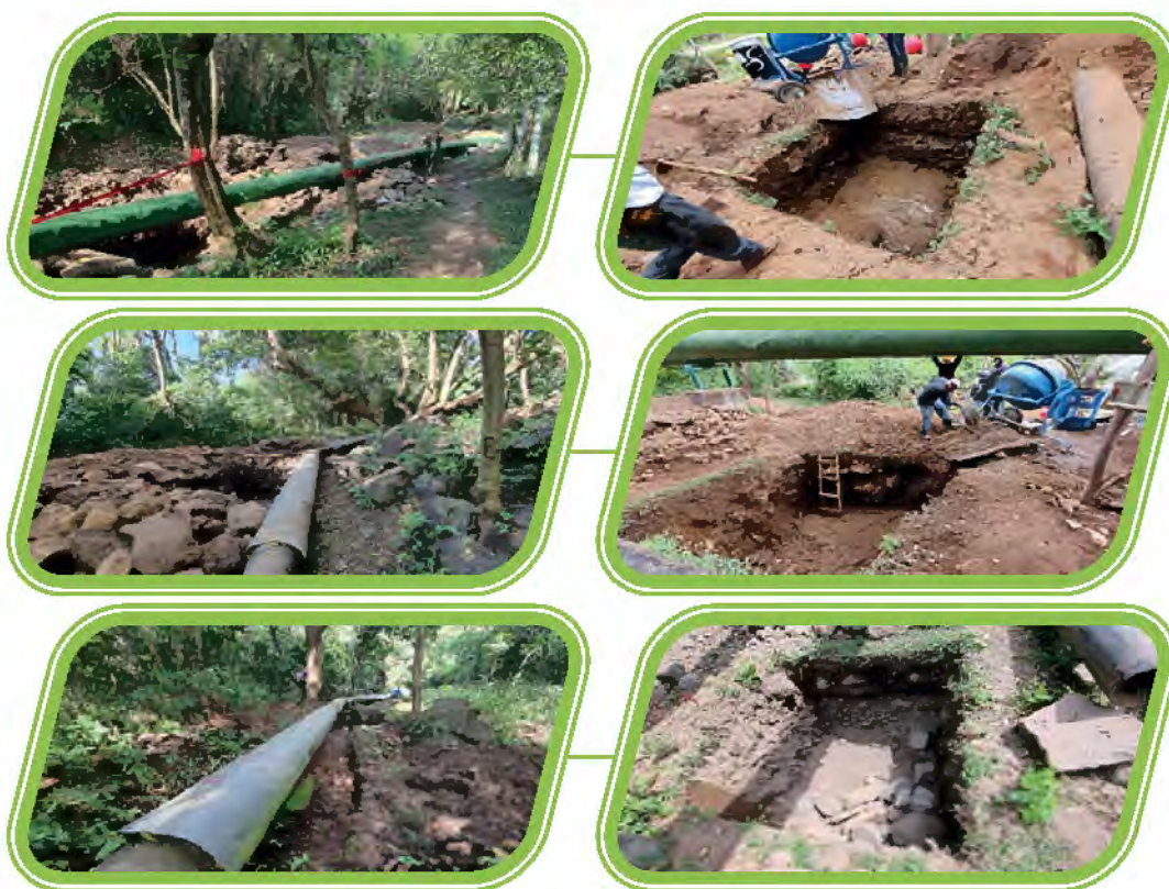
Construcción de obras civiles y mecánicas para el montaje de línea de reinyección en frío, desde la Central Geotérmica Ahuachapán hasta el pozo AH-2R
