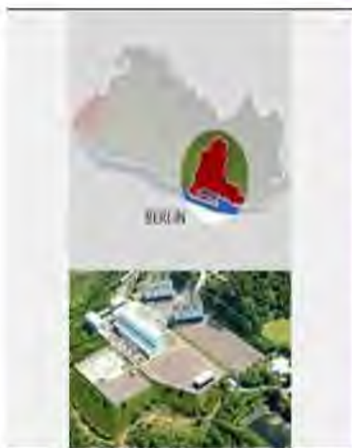
BERLÍN. Vista aérea de la Central Geotérmica.
