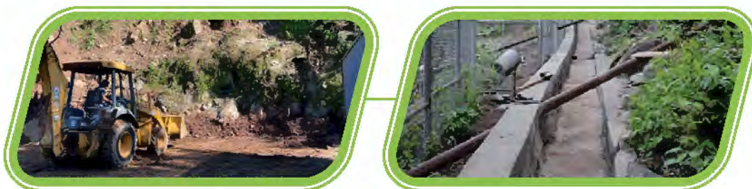
Limpieza y desalojo de material de derrumbe, por material suelto y rocas, construcción de canaleta y malla ciclón sobre talud de plataforma TR-1.
