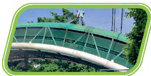
Rehabilitación de pasarela peatonal.
