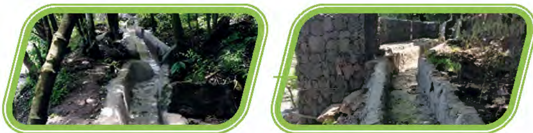
Reconstrucción de malla ciclón, construcción muro gavión y canaleta geotérmica.
