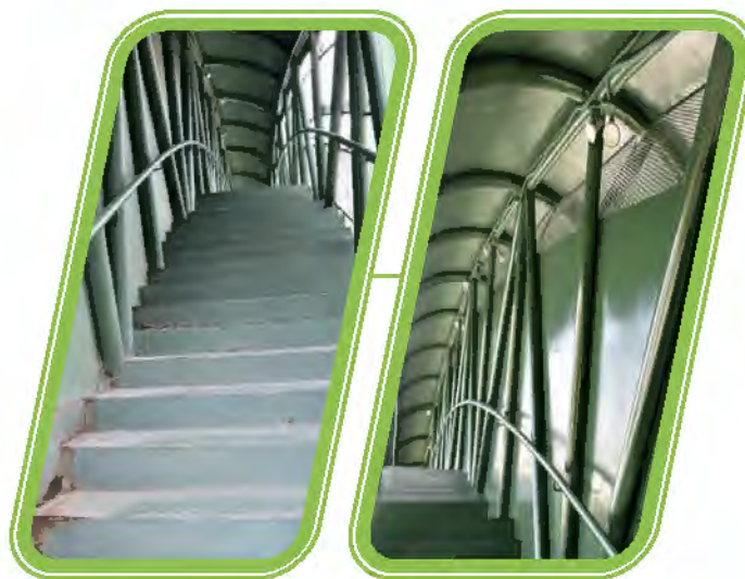
Trabajos realizados en pasarela Berlín.
