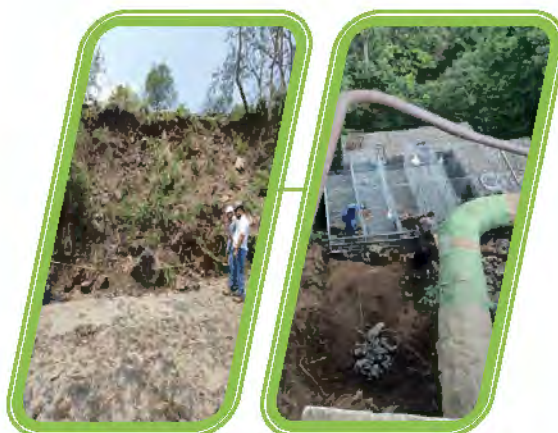
Trabajos realizados en taludes
