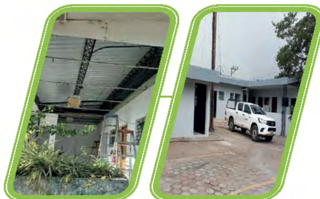
Trabajos realizados en campamento.
